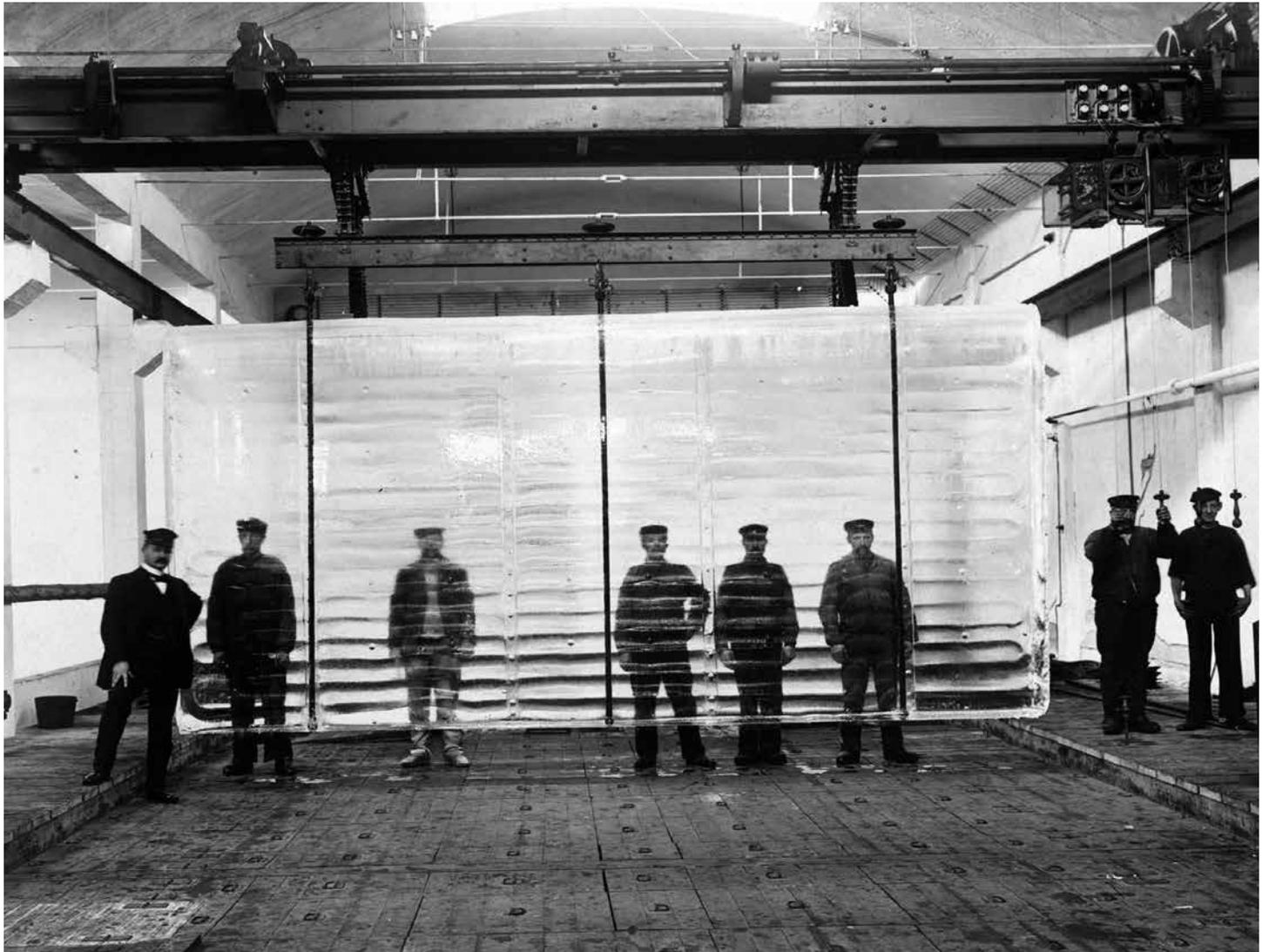
*Bild: Das Eisplattengewicht betrug bis zu 12.000 Pfund.*
