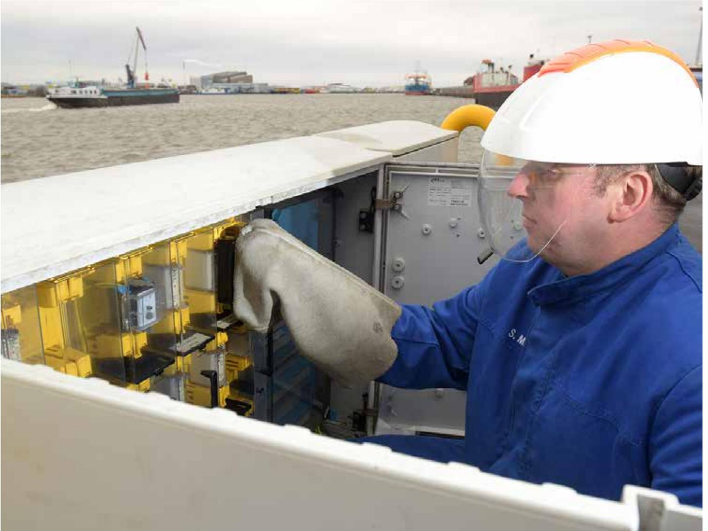
*Bild: FBG-Mitarbeiter beim Einsetzen einer Sicherung im Schaltschrank für Landstromanschlüsse für die Berufs- und Sportschifffahrt*
