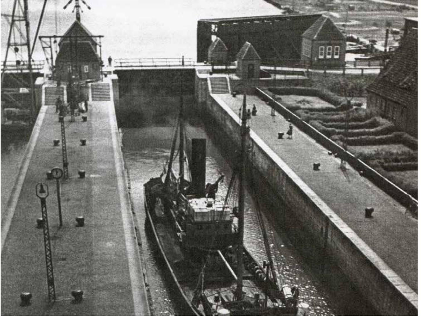
*Bild: Doppelschleuse mit Schiff in der kleinen Kammer*
