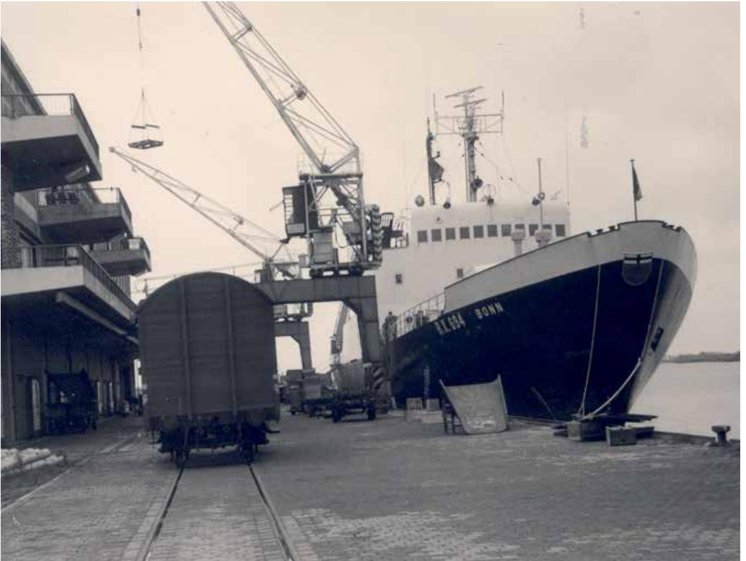
*Bild: Der Vollfroster BX 694 Bonn (Baujahr 1964) der Norddeutschen Hochseefischerei AG beim Entladen. Wo früher Muskelkraft eingesetzt wurde, traten nun Kräne in Aktion, die die Ladung direkt in die Eisenbahnwaggons hieven konnten.*
